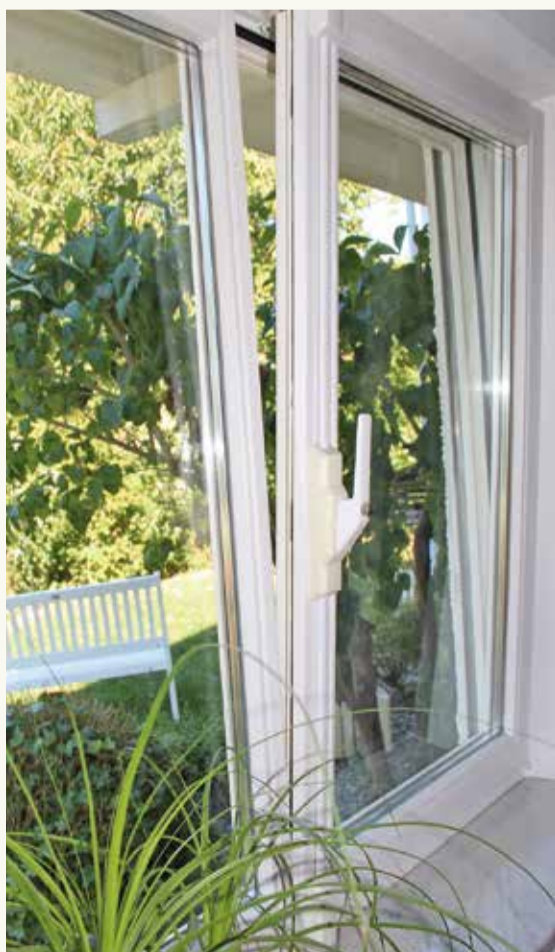
Falsche Lüftung – Fenster gekippt.
